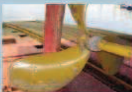
海中生物や汚れを除去した状態
